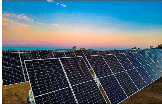
Woolooga Solar Farm (214MWDC)
